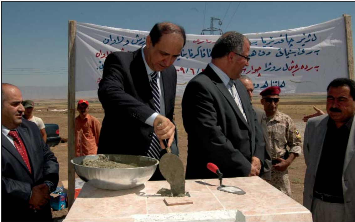
بەرپۆه بەری گشتی وەرزش و یاریە میلیییەکان لە دانانی بەردی بناغە ی پروژە یەکی وەرزشیدا
