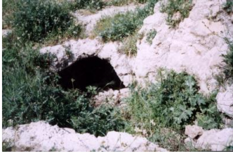
نمای بالای چپای ولکه و قسمتی از سقف ساروجی یکی از اتاقهای آن که فروریخته است
