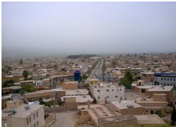
نمای شهر گیلان غرب داخل شهر
