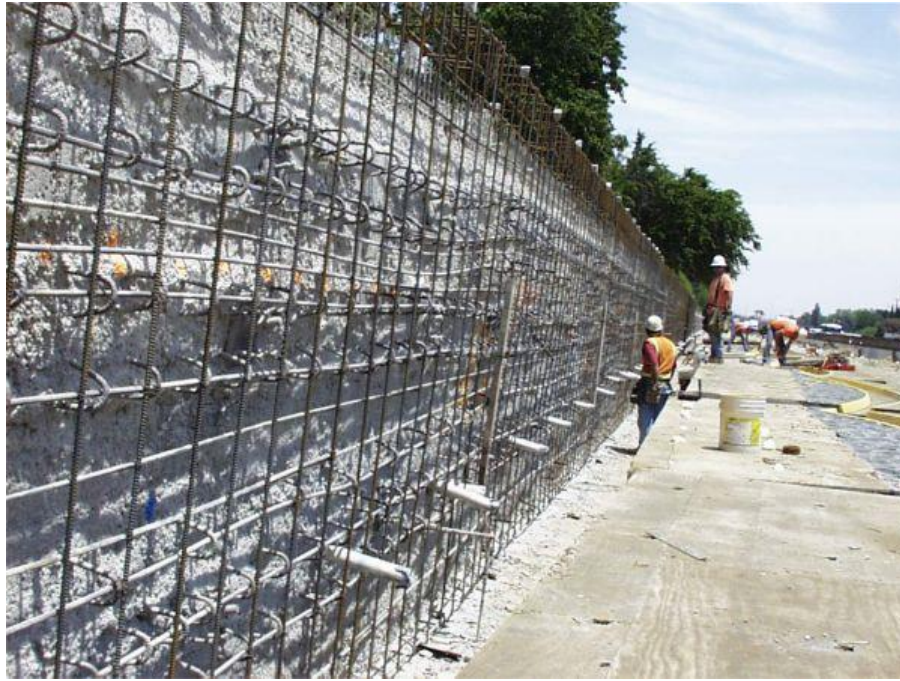
هه‌لواسینی شه‌به‌که‌ی شیش و ده‌رکه‌وتنی شیشی چه‌قیووی ناو دیواره‌که
