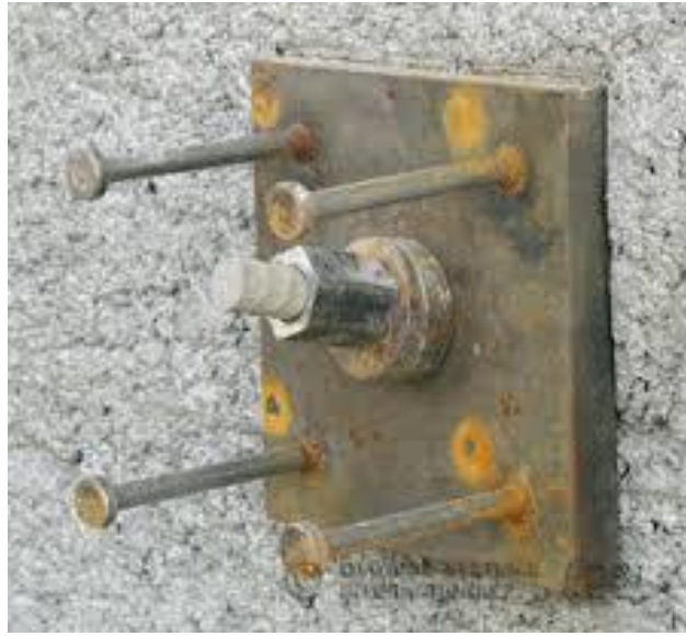
بهستنه وهی سهری شیشه که به سه مونه و واشه ره وه به دیواره کونکریته که وه
