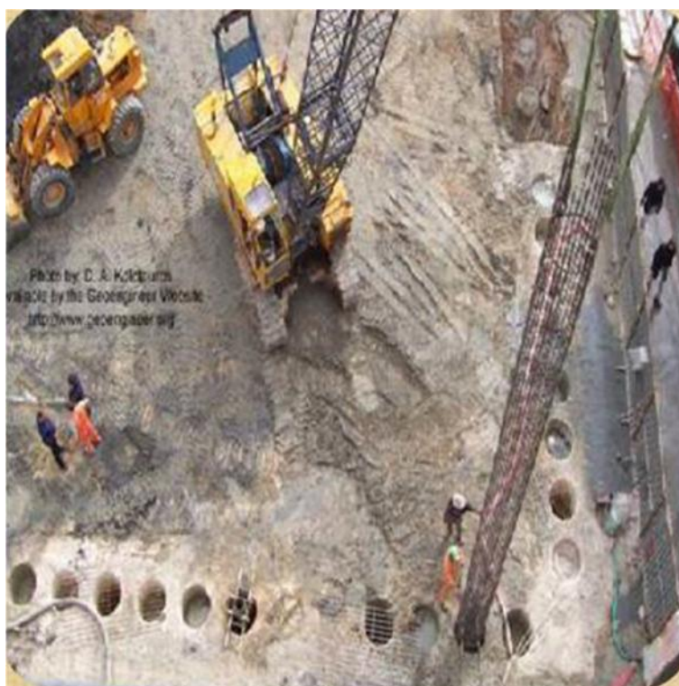
شیشی بهستراو دهخریته ناو چاله‌کانه‌وه و ئاماده‌کردنی بو کونکریت کردن
