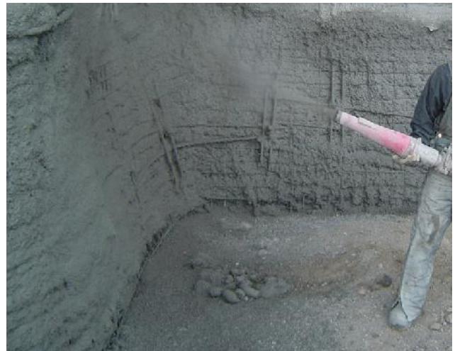
پرزاندنی کۆنکریت به په‌ستانیکی به‌رز و به ئامیری تاییه‌ت
