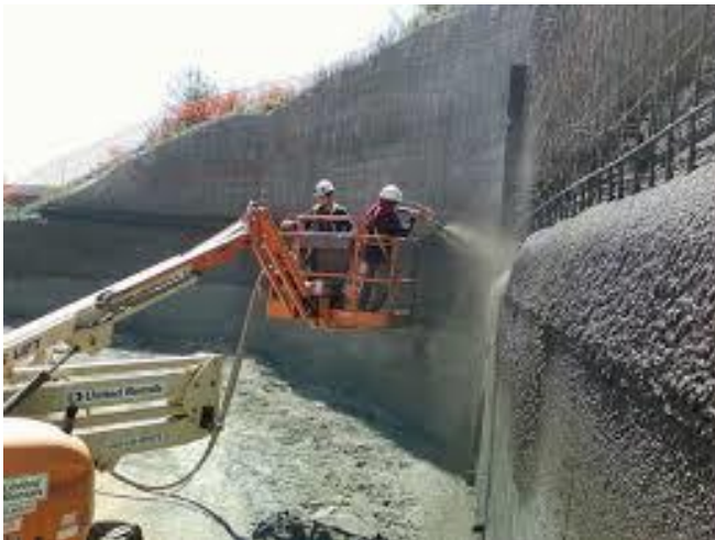
پرزاندنی کۆنکریت به په‌ستانیکی به‌رز و به ئامیری تاییه‌ت
