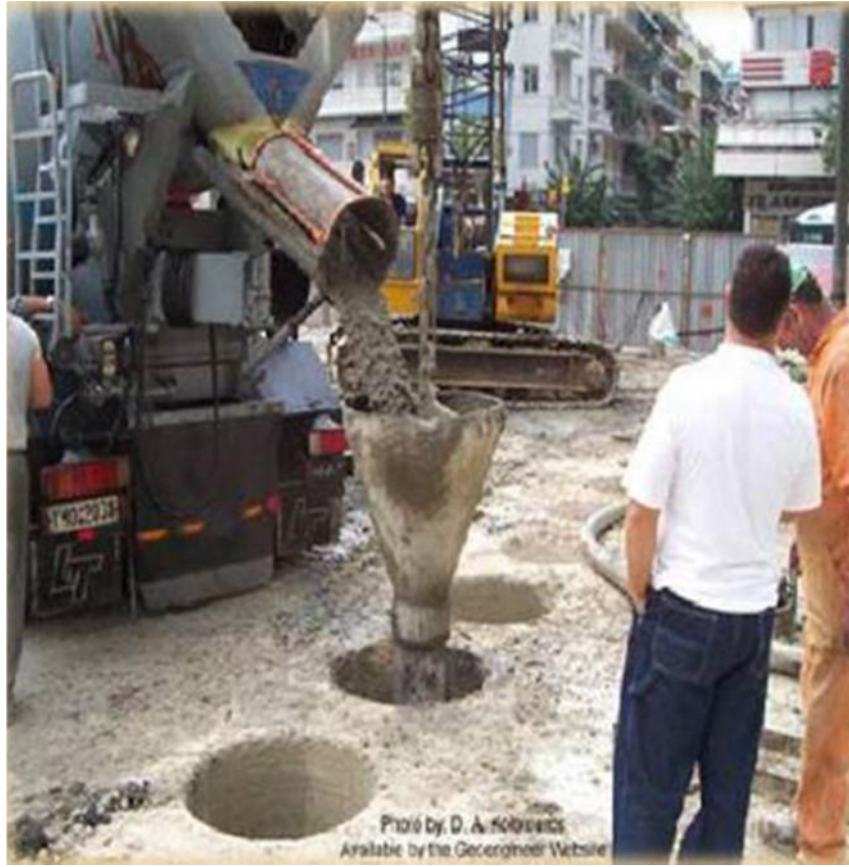
کونکریٹ کردنی Pile
