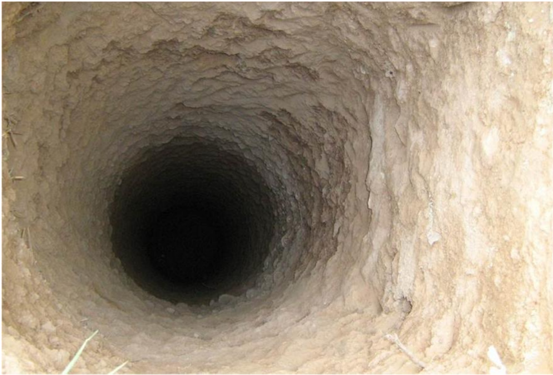
وونہی چالیکی ھلکھندراوی نامادھکراو بو شیش و شیلمان پاشان کونکریت کردن
