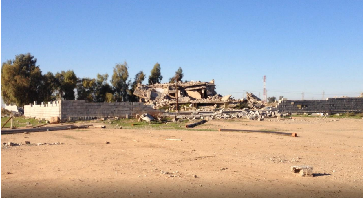
واحد من المنازل التي دُمِّرَتْ في إدريس خنزعل أصيحت دماراً شديداً، هي ظلال سقوف مدمجة. © 2015 يومن راييس ووتش
