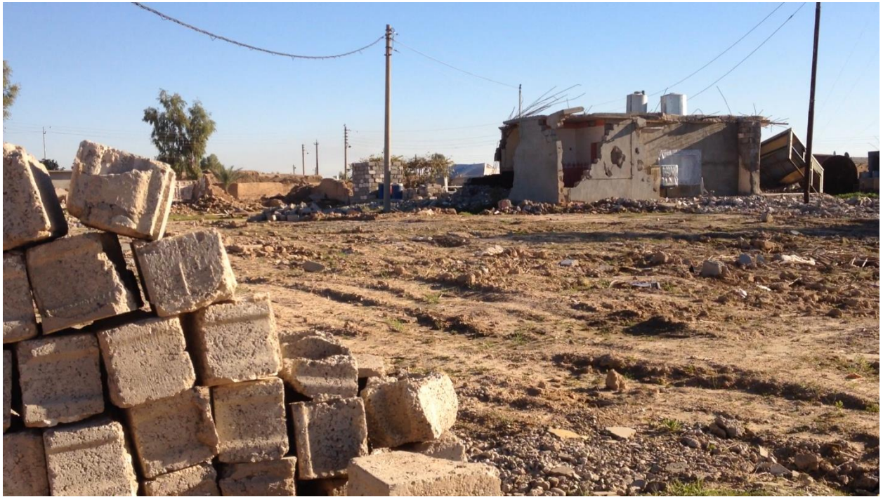
أعمال الهدم لتدمير في إدريس خباز. © 2015 يومن راييس ووتش
