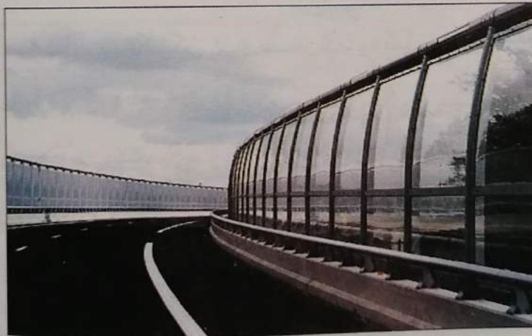
وینەى ۲.۲۳: نمونەییەك لە دیوارى شوشەیی بۆ هەلمژینی دەنگ
