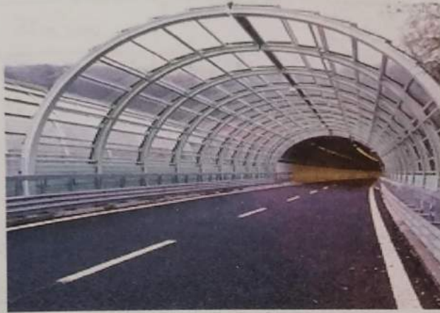
وینەى ۲.۲۲: نمونەییەك لە دیوارى شوشەیی بۆ هەلمژینی و كەمکردنەوهی دەنگ
