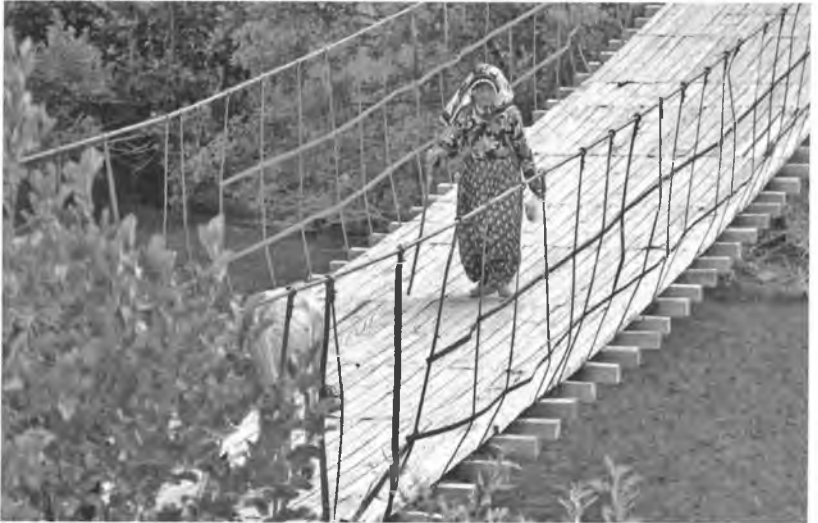
Munzur ve Harçık sularının üstüne kurulan asma köprü. 1937 olaylarını başlatan Pah Köprüsü de bu köprünün benzeriydi.
