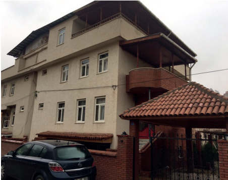
Fotoğraf 1: Çalışma mekanı ön cephe görünüşü
