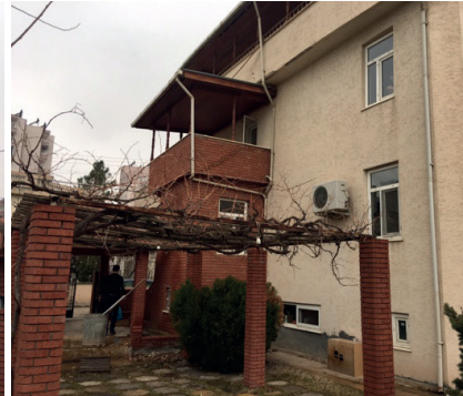
Fotoğraf 2: Çalışma mekanı yan cephe görünüşü
