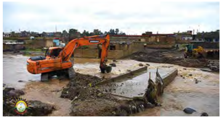
Aufräumarbeiten nach der Überschwemmung 2019
