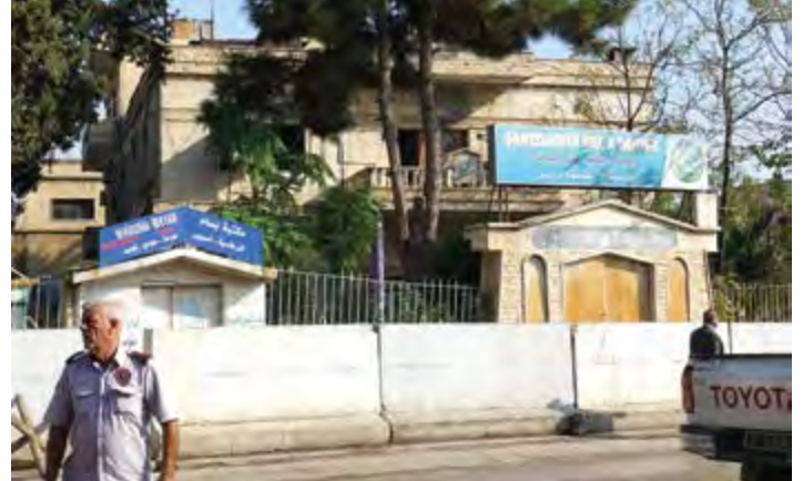
Das Rathaus von Dêrik mit Schutz vor Autobomben
