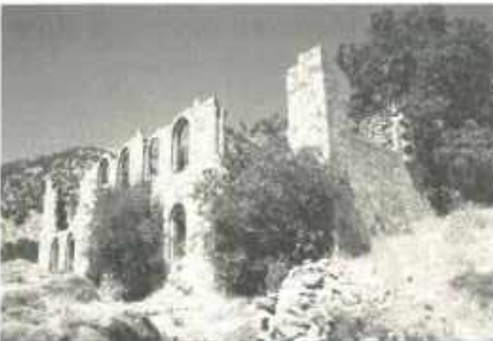
Fotoğraf: 7 Şemdinli Kayme Konağı Kuzeybatı Görünüşü
