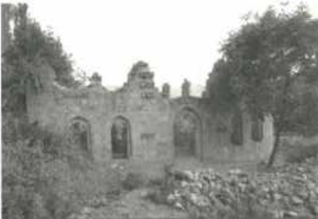
Fotoğraf: 13 Şemdinli Kayme Konağı Kuzey Cephe Kazı Çalışmaları Görünüşü
