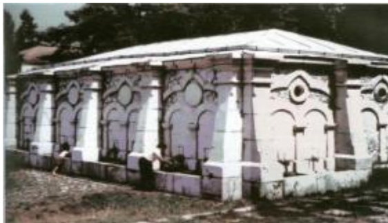
В 1872 году Хуршид Бану Натаван построила в Шуше на свои средства первый водопровод. В районах города были установлены распределительные пункты, названные в народе родниками - булагами. На снимке основной распределительный пункт - "Хан гъзы булагы".
