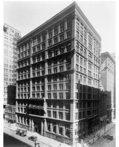
بینای ئینشورانسی زهوی و زار، شیکاگو - ۱۸۸۵. به یه‌که‌م بینای به‌رز skyscraper دائه‌نریت
