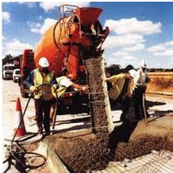
شىۋەى (4-8) تىكردىنى كۆنكرېتتى وشك تارادەيەك پىۋىستى بەبەكارھىنانى لەرلەر كەر ھەيە بۆ كاتىكى درىژ
