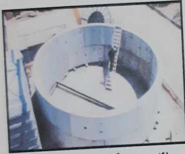
حلقات خرسانية ذات تجويف بقطر ٨,٣٥ متر (مترو أنفاق القاهرة)
