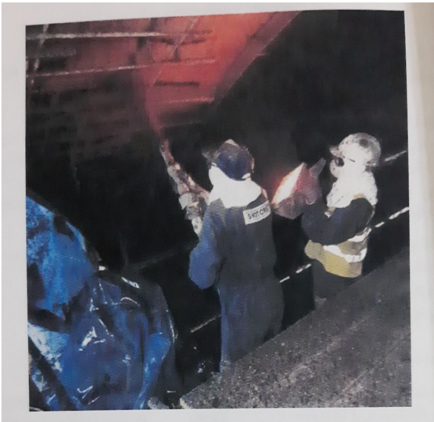
شىوہى(3-20) پروونكردەوہى بەكارھىنانى كۆنكرېتى ھاويژراو لە يەككە لە تونيلەكاندا
