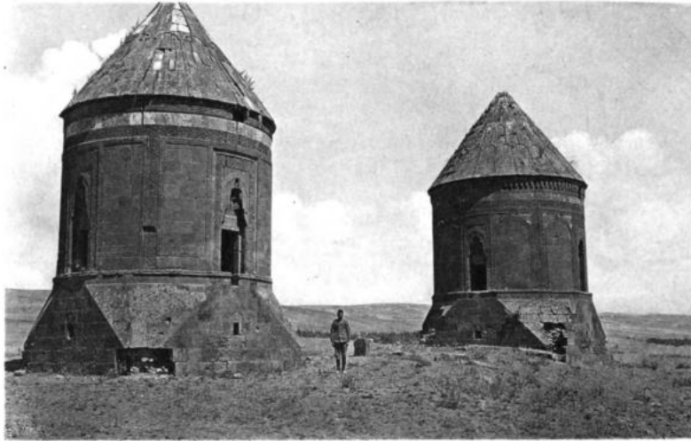
GESAMTANSICHT (VORN Nr. 2, HINTEN Nr. 1)
