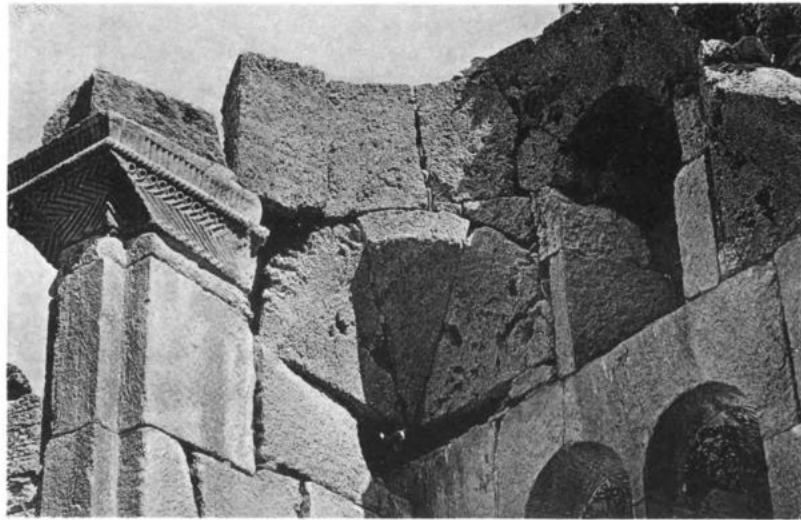
NISCHENGEWÖLBE UND PFEILERKAPITELL
