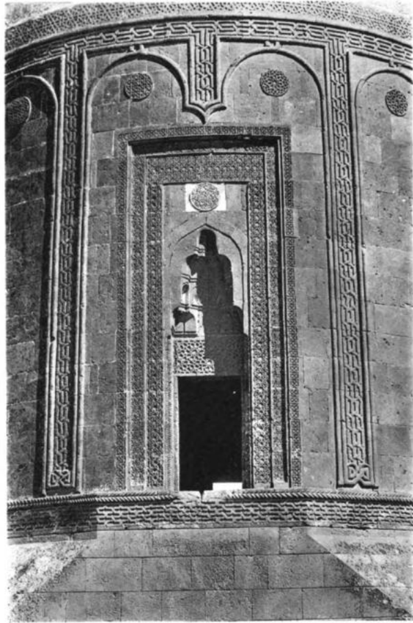
FENSTER AN DER WESTSEITE
