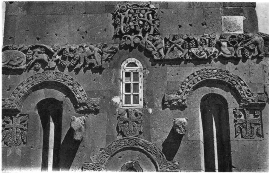
DIE OBERE HÄLFTE DER WESTWAND
