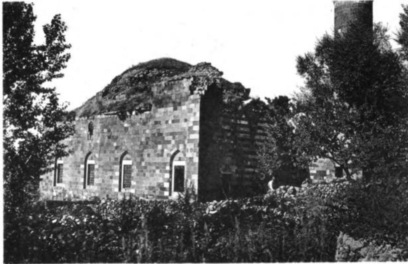
GESAMTANSICHT VON NORDOSTEN
