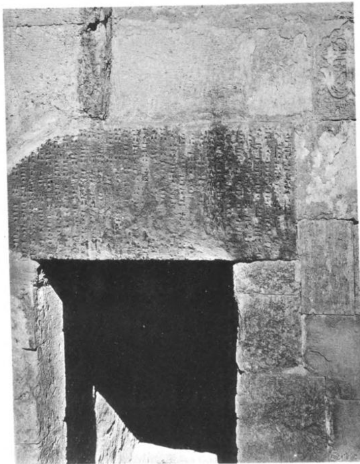
TÜRSTURZ ÜBER DER NÖRDLICHEN SEITENTÜR
