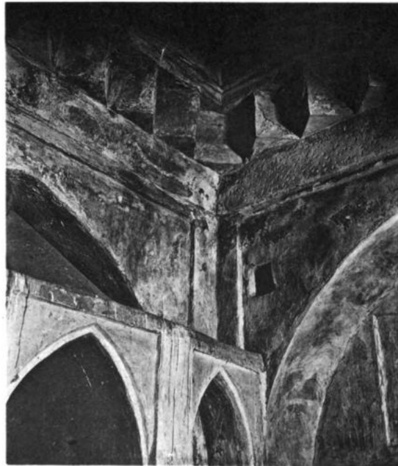
GEWÖLBEANSATZ IN RAUM 5
