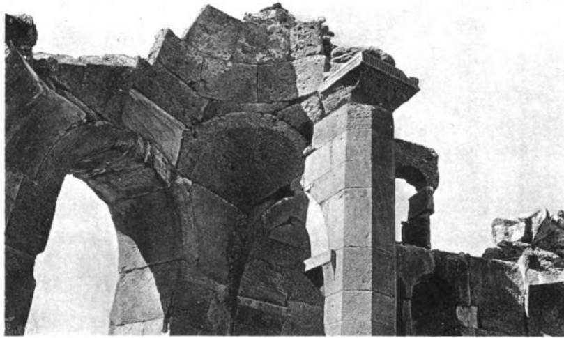
FENSTERBOGEN UND ANSATZ EINES NISCHENGEWÖLBES
