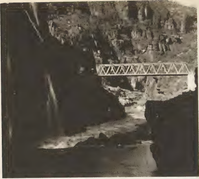
Rewanduz Nehri üzerindeki ana köprü.
