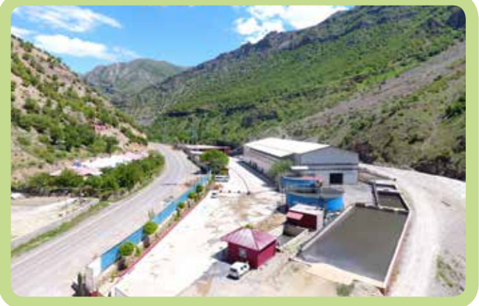
Hakkâri Maden Tesisi
