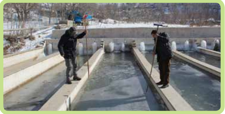
Hakkâri Balık Tesisi
