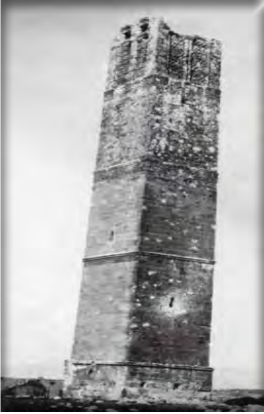
“Görsel 3.38 'Rasathane (Gözetleme Kulesi)’”
