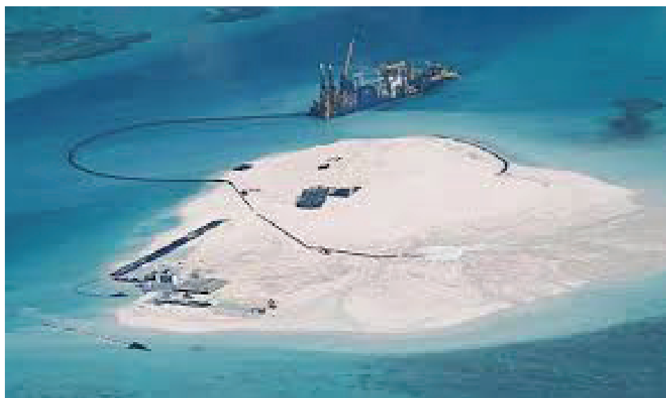
تقنية ضخ الرمل والكونكريت في الشعاب المرجانية من البواخر الخاصة بعمليات الانشاء
