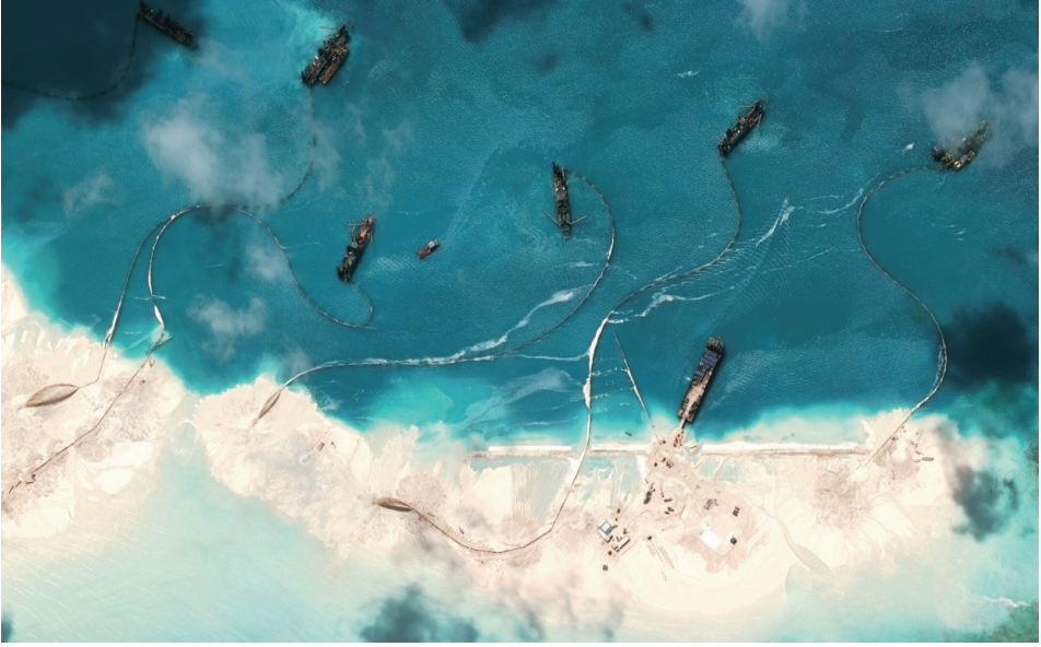
الآليات العائمة الثقيلة تقوم بعمليات البناء
