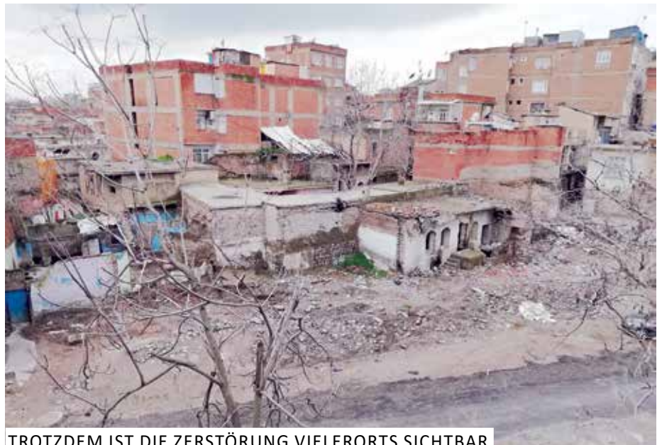
TROTZDEM IST DIE ZERSTÖRUNG VIELERORTS SICHTBAR.
