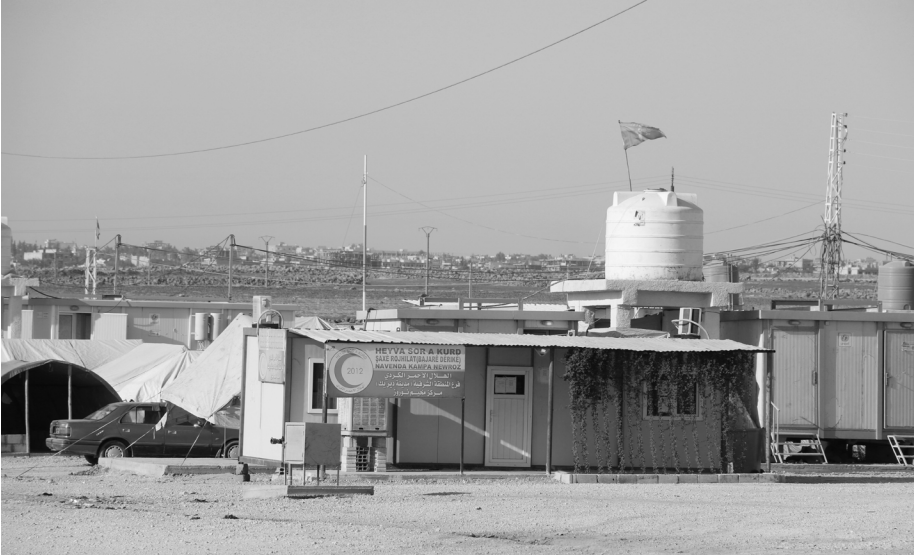
Abb. 11: Verwaltungsgebäude des Kurdischen Roten Halbmonds im Newroz-Camp, September 2016. Foto: Thomas Schmidinger
