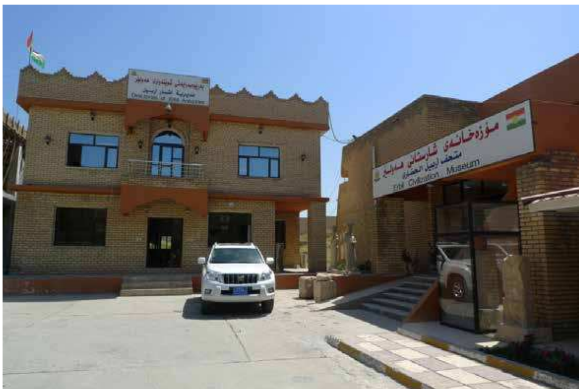
Fot. 8. Budynek Dyrekcji ds. Starożytności, po prawej stronie widoczne Muzeum Starożytności
