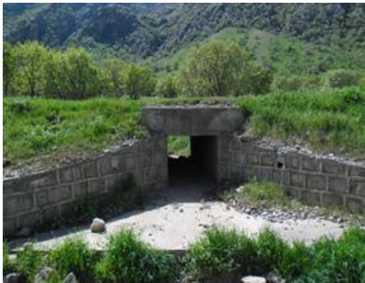
صورة (15) انشاء السيفونات اسفل الطرق الجبلية لتصريف السيول
