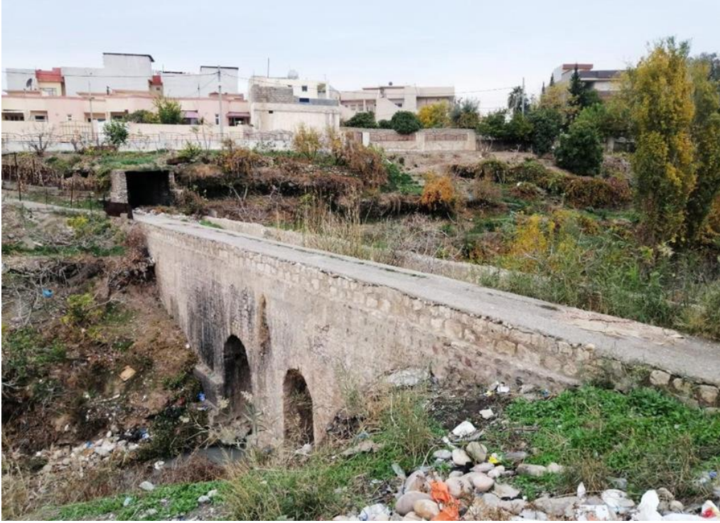
الصورة (١) القنطرة والنفق أو (القناة) تحت البيوت السكنية/ تصوير الباحثة
